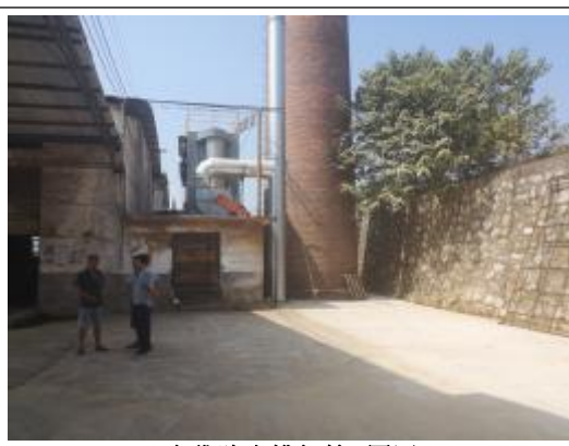
布袋除尘排气筒-图四
